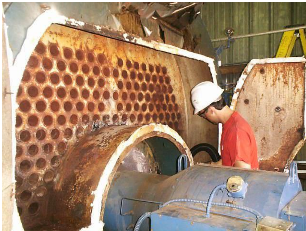
خوردگی و پوسیدگی در دیگ بخار
